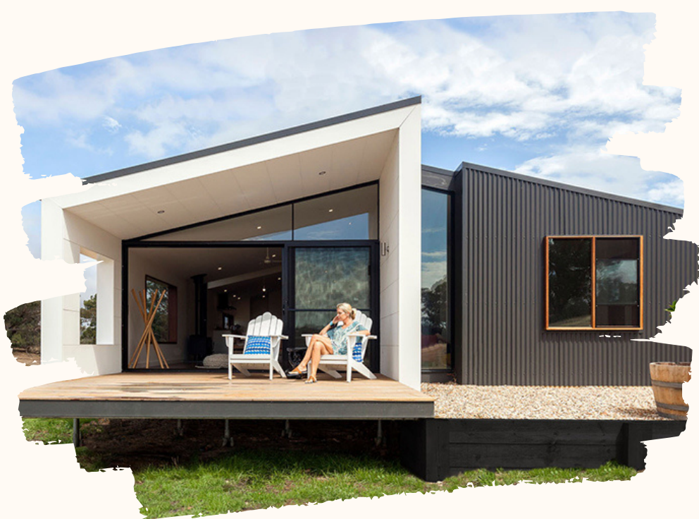
บ้านประกอบเสร็จ
